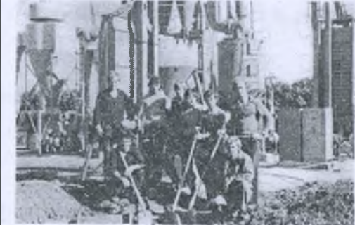
НЕДАВНО поступили в институт эти ребята, они студенты 4 группы I курса факультета механизации. С первых дней августа им поручено работать на строительстве нового кормоцеха в учебно-опытном хозяйстве института. С высокой трудовой дисциплиной и хорошими результатами бригада заканчивает выполнение задания.
